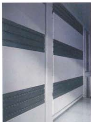
壁面にファーノトラック を横向きに設置した状態
